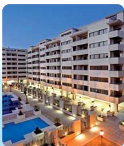
Residencial Litoral Beach. 368 viviendas (Málaga).
