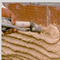
Amasar el mortero aislante termo-acústico **webertherm aislone** mecánicamente con 5,5 – 6 litros de agua limpia por saco, y aplicar de forma manual o por proyección mecánica.
