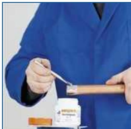
Es importante que el fundente se aplique solo en una capa fina en el extremo exterior de la soldadura del tubo/accesorio, de forma que no entre más que una parte, técnicamente inevitable, de fundente en el interior del tubo.
