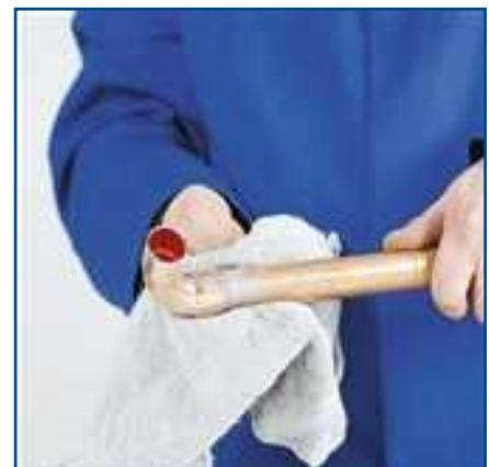
La eliminación de los fundentes de la soldadura blanda puede realizarse, por ejemplo, con un paño húmedo, y la de los fundentes de la soldadura fuerte, por ejemplo, con un cepillo de latón, por su condición vidriosa.
