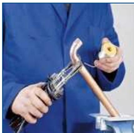
La soldadura blanda debe fundirse, pero sin exposición directa a la llama, sino en el punto de soldadura a la temperatura adecuada. Por el contrario, la soldadura fuerte se lleva a cabo con la llama sobre las piezas que brillan de color rojo cereza.
